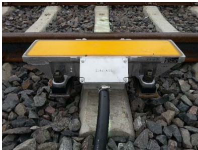
Abbildung 13: Gleismagnet für PZB
